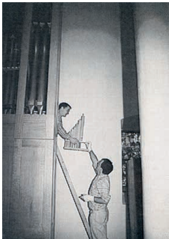
Holzpfefen werden in die Orgel eingesetzt
